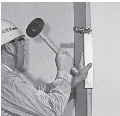
写真3-2 クリンチャーの使用例
