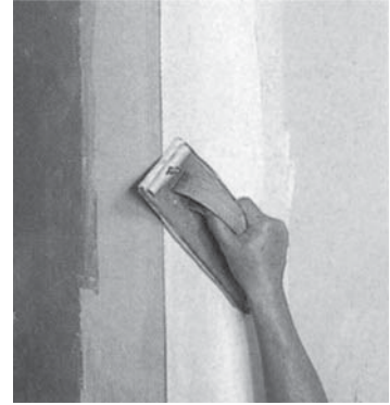
ブロックサンダー 120番程度のサンドペーパーを 装填最終仕上げ
