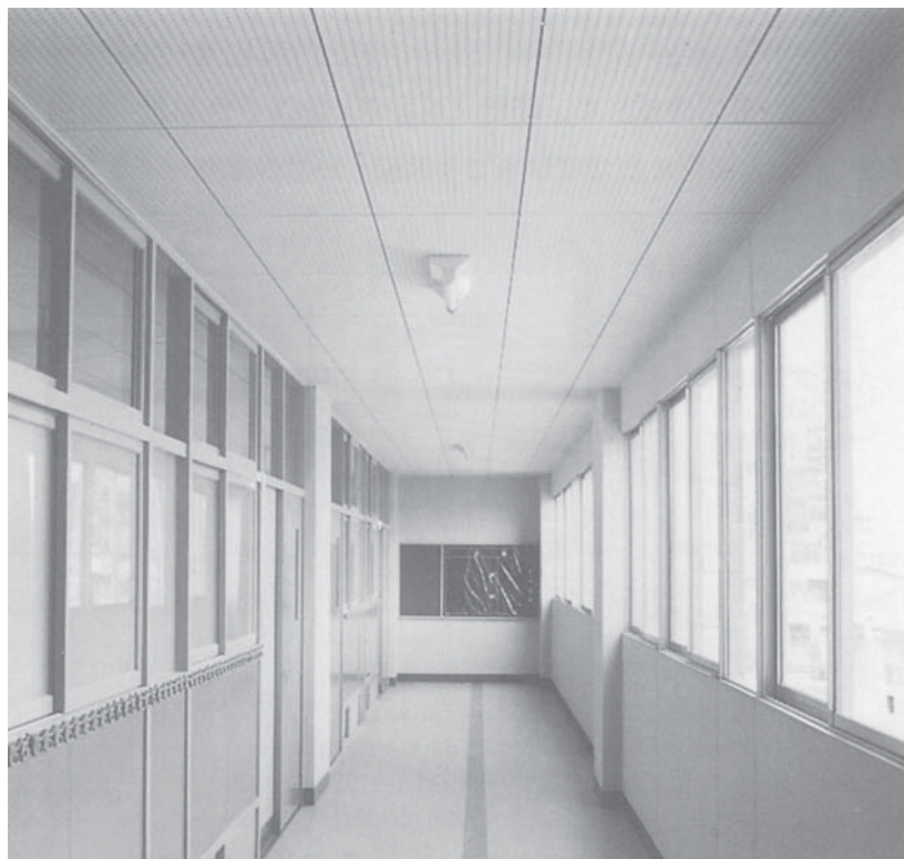
写真3-9 吸音用あなあき石膏ボード（例1）
